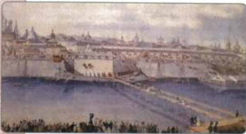
Закладка нового металлического моста через Москву-реку в 1838 г. Художник К. К. Гампелы
