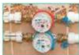
Рис. 4.7. Измерительные приборы и функциональные аппараты: а — счётчик (прибор) для измерения расхода воды; б — прибор для измерения кровяного давления; в — сварочный аппарат
