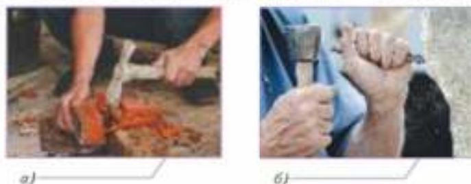
Рис. 5.20. Рубка камня: а — с помощью молотка-кирочки; б — с помощью зубила
