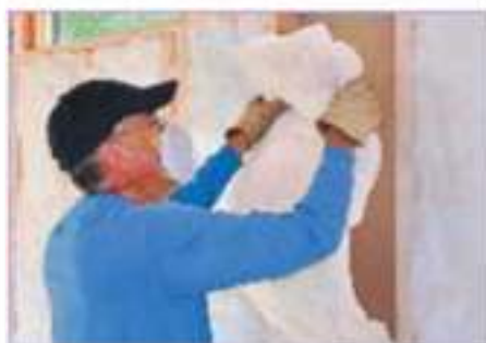
Рис. 9.13. Уменьшение потерь тепловой энергии — утепление стен домов
