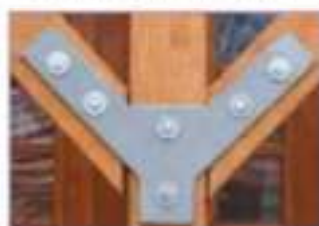
Рис. 6.4. Крепление деталей из древесины на болтах
