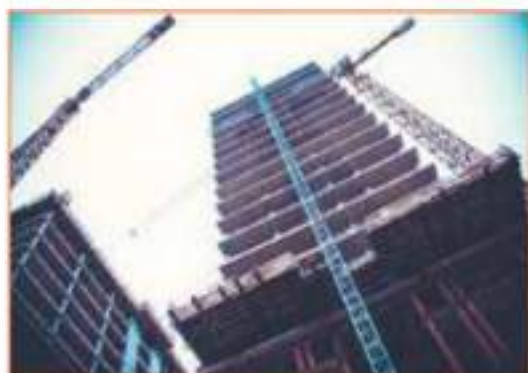
Рис. 7.1. Монолитное строительство с применением химического фрезерования
